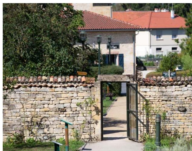
Le mur de clôture est réalisé en pierre sèche.
