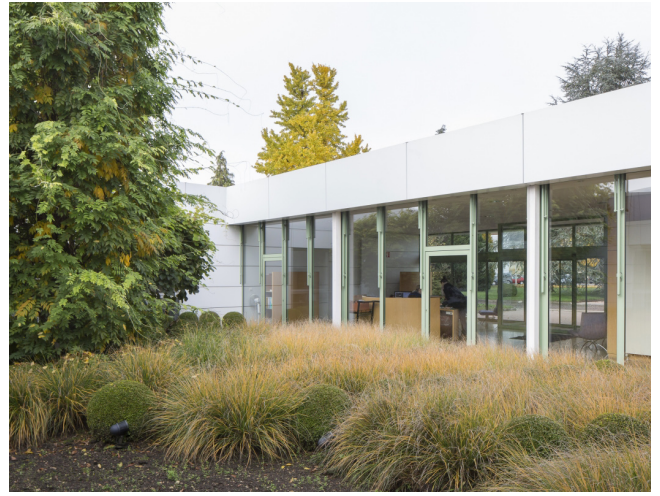
La façade donnant sur le patio est rythmée par la structure en métal et les éléments préfabriqués. Source : Photographie Olivier Mathiotte, la Manufacture du Patrimoine Droits : DRAC Lorraine
