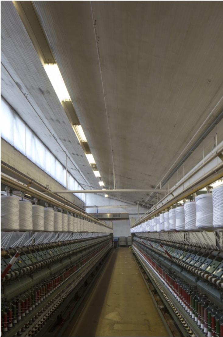
La sous-face lisse d'un shed est éclairée par la lumière diaphane du bandeau vitré. Source : Photographie Olivier Mathiotte, la Manufacture du Patrimoine Droits : DRAC Lorraine
