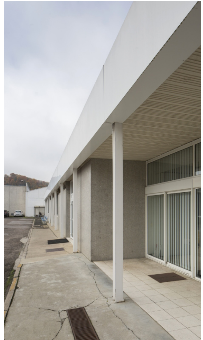
La façade arrière des bureaux est revêtue de céramique et scandée par les poteaux métalliques. Source : Photographie Olivier Mathiotte, la Manufacture du Patrimoine Droits : DRAC Lorraine
