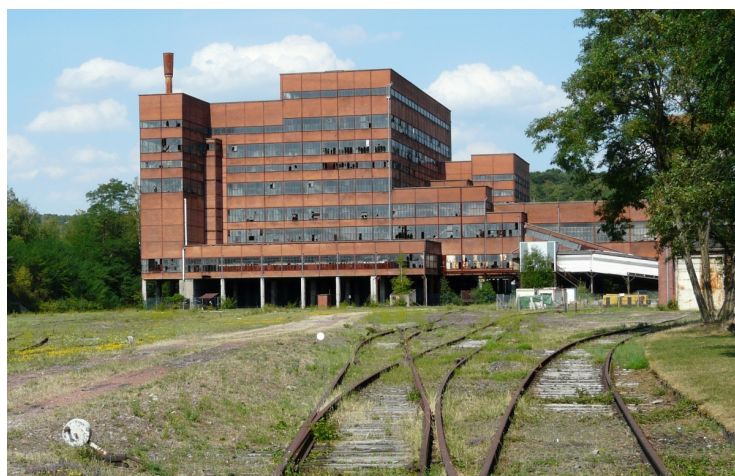
Le lavoir Wendel 3 est le plus monumental des deux. Son volume aux lignes épurées est mis en valeur par l'alternance des bandes de vitrages et de briques.
