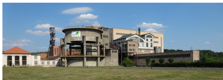
L'architecture complexe du lavoir Wendel 1-2 témoigne à elle seule de l'évolution du site. Sa réhabilitation partielle est également l'œuvre de l'architecte Philippe Jean.
