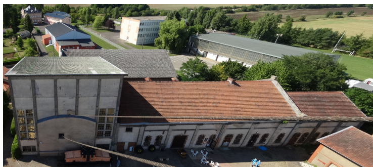
L'architecture de béton de la salle des machines contraste avec les bâtiments du début du XXe siècle.
