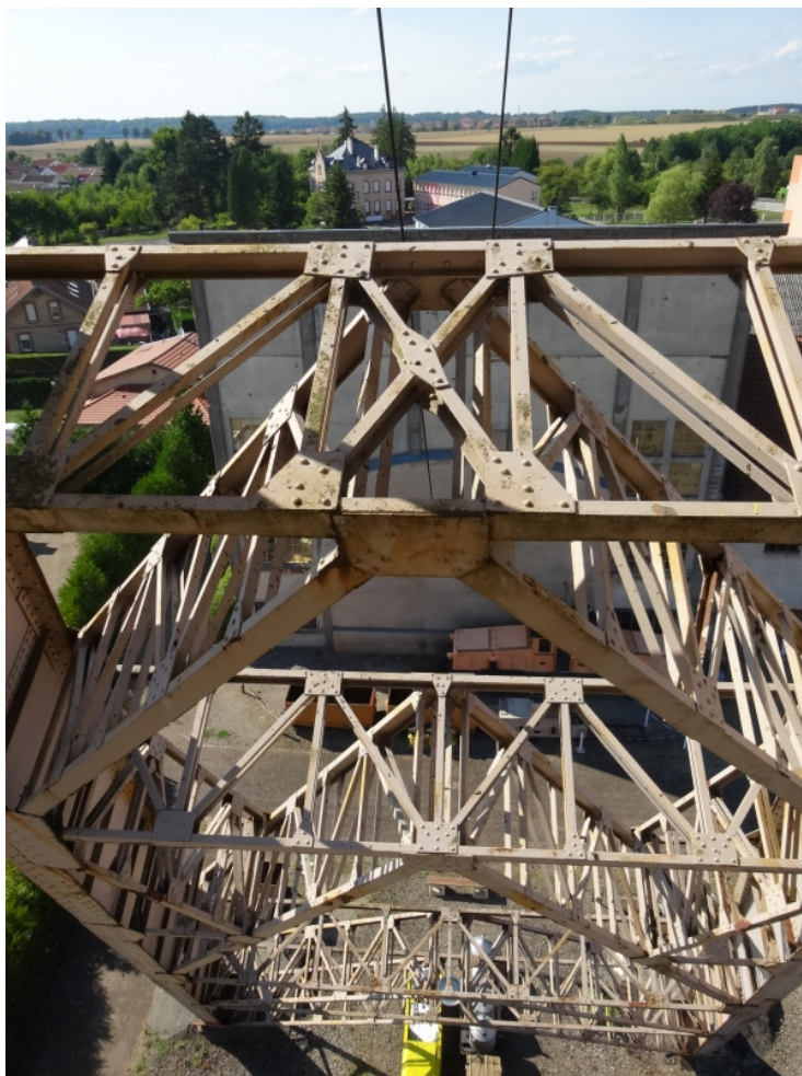
La structure rivetée de l'imposante jambe de force du chevalement participe à la reprise des efforts de traction lors des opérations d'extraction du puits.
