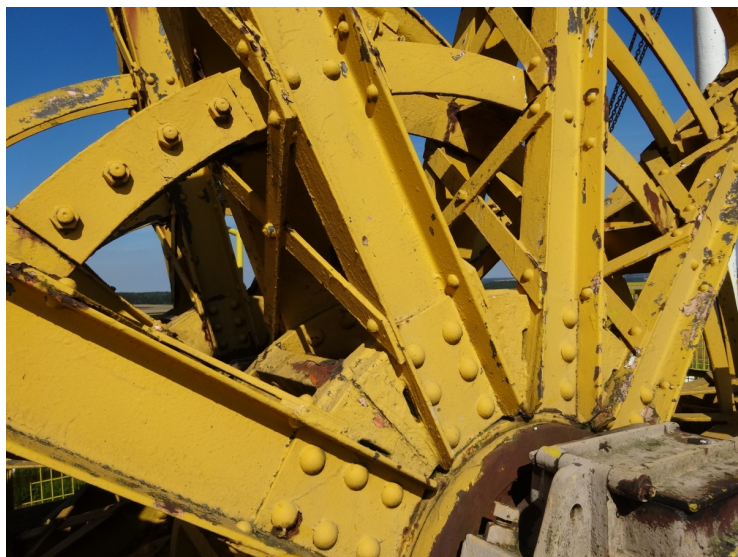
Les molettes de 5 mètres de diamètre sont observables depuis la plateforme du chevalement.
