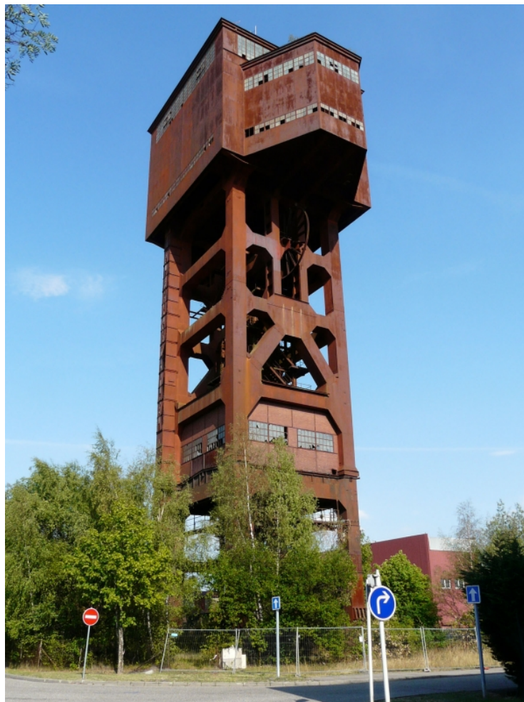
Isolée, la tour d'extraction du puits n°1 surgit au centre de ce qui est désormais une zone industrielle.
