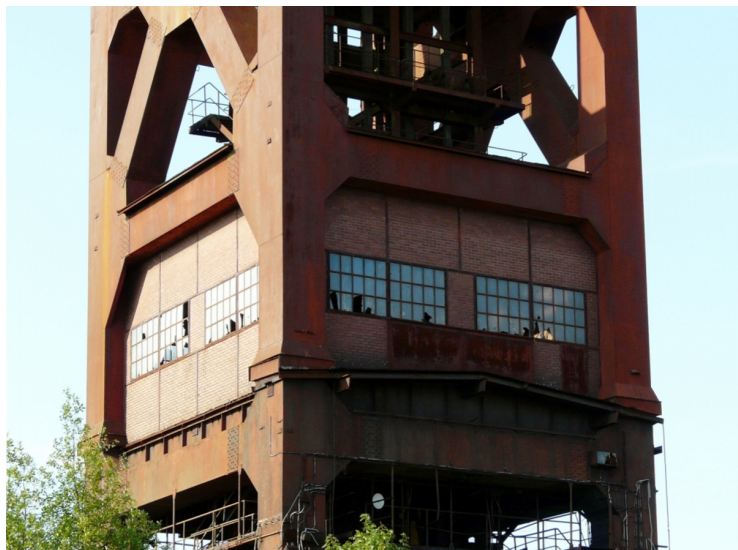
Le volume de briques inséré au premier étage de la tour abritait des bureaux.
