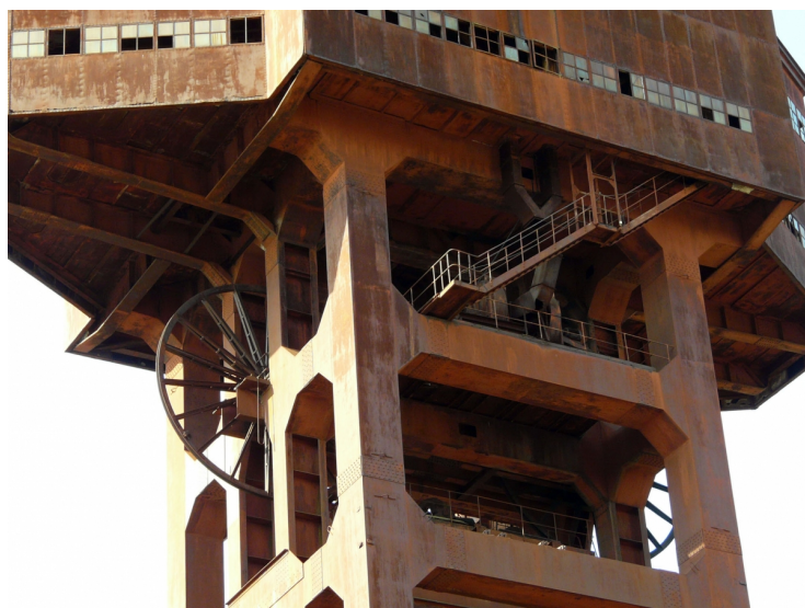
La tour d'extraction se différencie d'un chevalement classique par sa forme de marteau, accueillant la salle des machines et la poulie.
