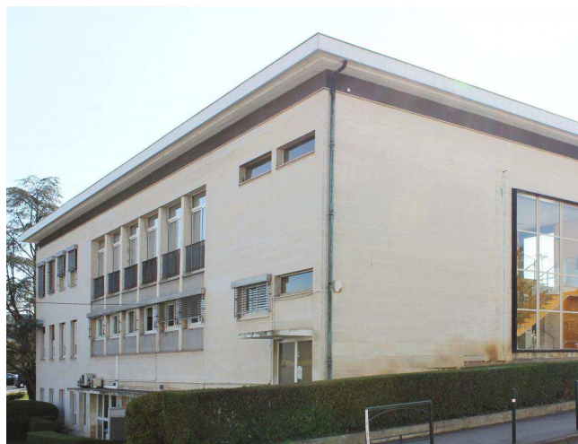
La façade arrière est plus simple, composée de façon rationnelle.
