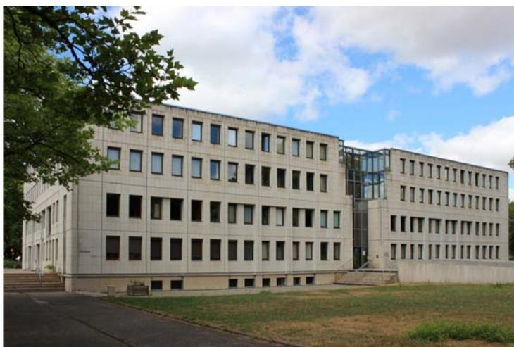
La façade principale rompt son austérité affirmée par une faille de verre marquant l'entrée. Les panneaux préfabriqués associent béton et pierre calcaire d'Euville en surface.
