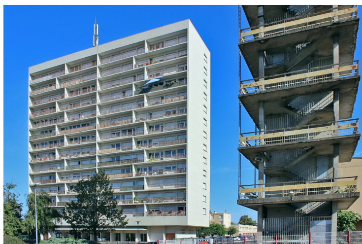
Les tours de logements et de séchage illustrent toutes deux la nouvelle écriture architecturale géométrique permise par l'emploi systématique du béton armé.
