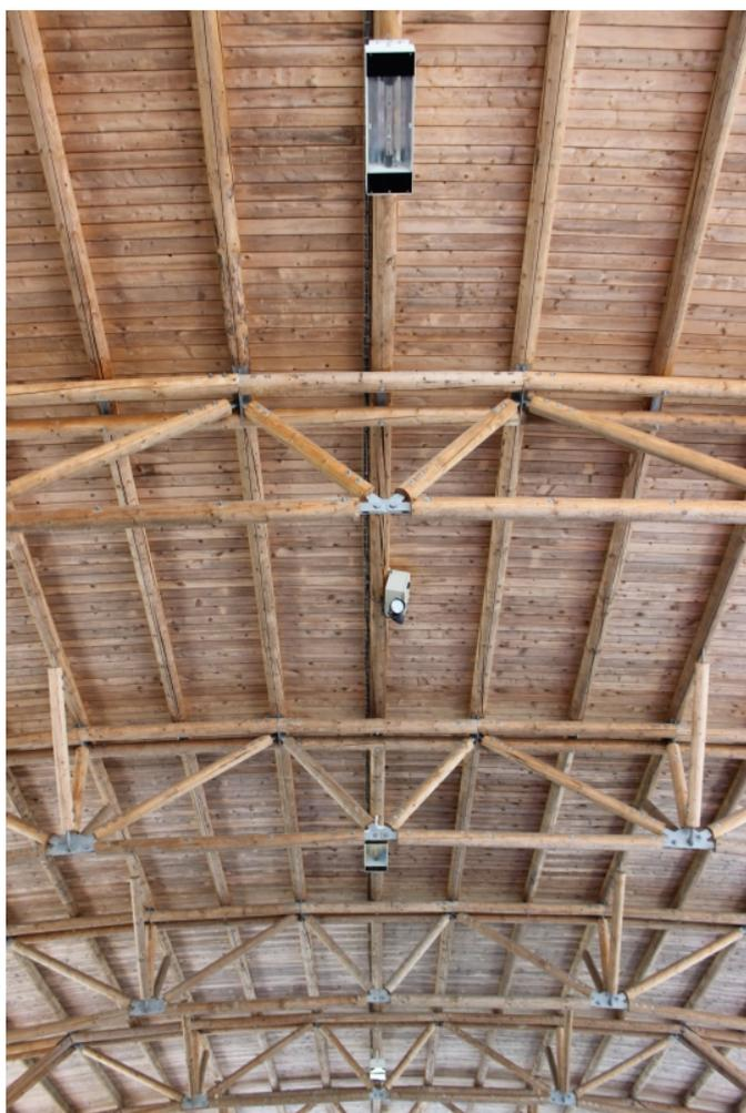
*La charpente, composée de pièces de bois ronds calibrés d'épicéa, intègre des éléments de liaison en métal.*
