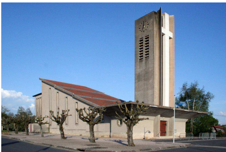
L'auvent marque le départ de l'inclinaison de la toiture.
