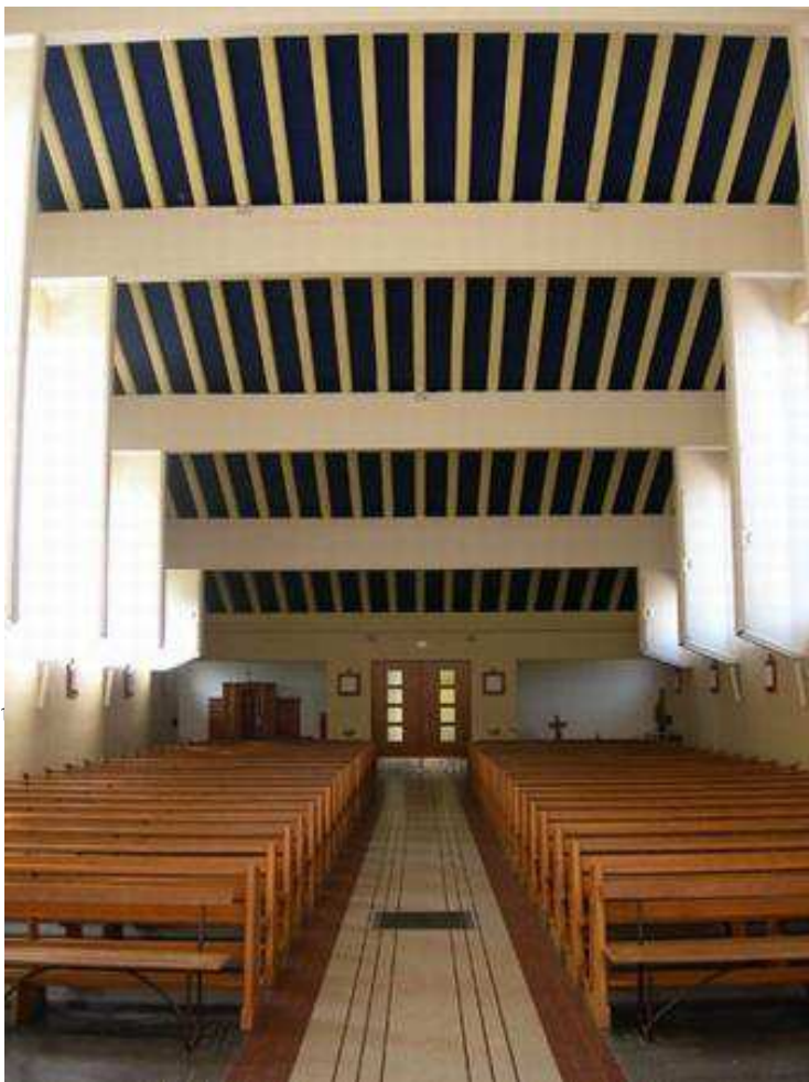
La charpente en bois de l'église est soutenue par des poutres reposant sur les murs extérieurs en béton armé.
