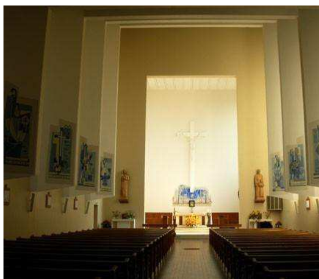
Les voiles en béton orientent la lumière naturelle vers le chœur.
