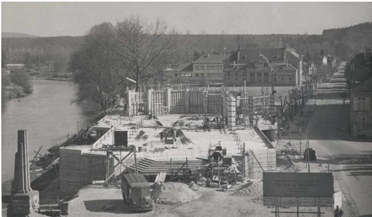
Après les travaux de terrassement réalisés entre 1953 et 1954 sont construits les premiers piliers en béton armé brut de décoffrage destinés à soutenir la charpente de l'église.
