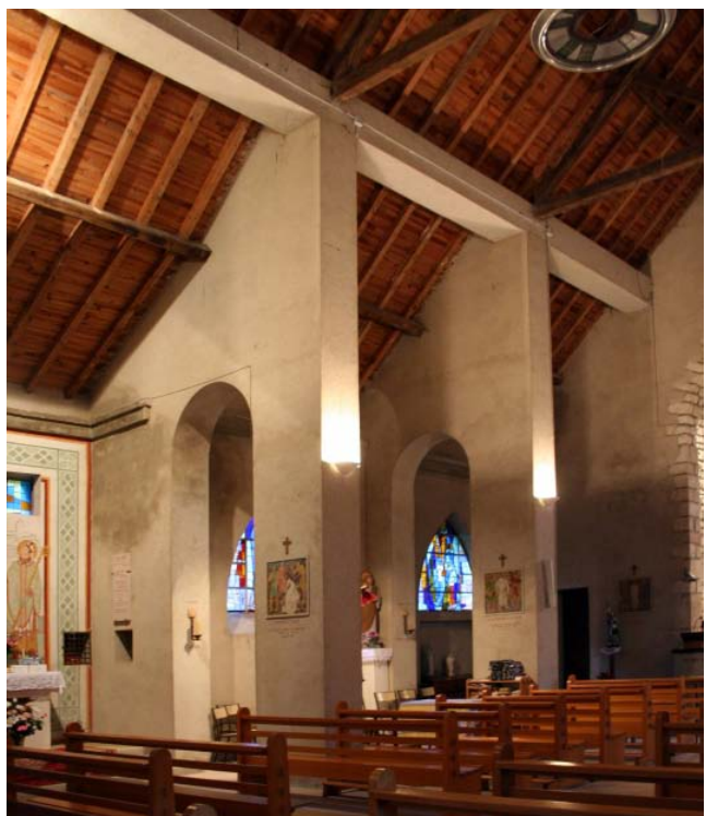
La charpente lambrisée de la toiture est soutenue par des murs en béton percés d'ouvertures en plein cintre.
