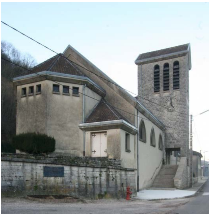
Côté sud, l'église se présente comme un édifice massif dominé par son clocher, hors œuvre, accessible par un escalier à double volée.
