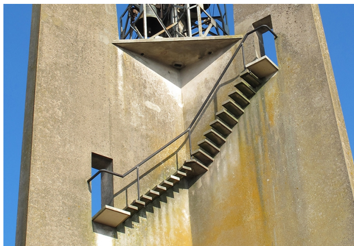
Muni d'une simple main courante et ne présentant ni limon apparent, ni contremarche, l'escalier extérieur qui se déploie tout autour de la tour-clocher, apparaît comme suspendu dans le vide.
