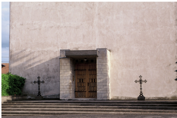
Le parvis, d'une grande sobriété, mène à l'entrée qui constitue la seule ouverture de cette façade.
