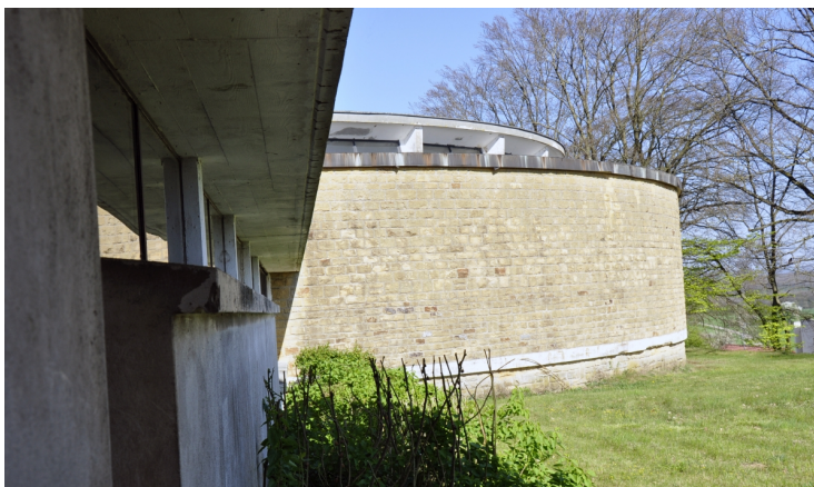
Adossé au grand mur, la galerie de liaison entre les deux volumes en moellons se démarque par le traitement épuré de sa maçonnerie de béton brut de décoffrage.
