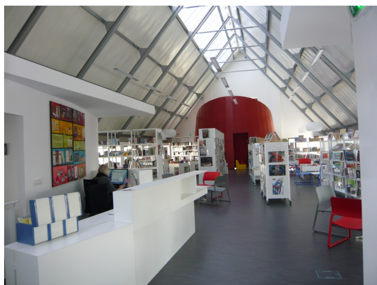
La présence d'une travée vitrée au niveau du faîtage, coté nord, apporte un éclairage zénital naturel propice à la lecture.
