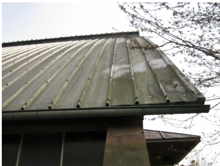
Le léger cintre de la couverture métallique d'origine, posée sur les plateaux de type "Rousseau", témoigne de la mise en tension de l'ouvrage par la charpente.
