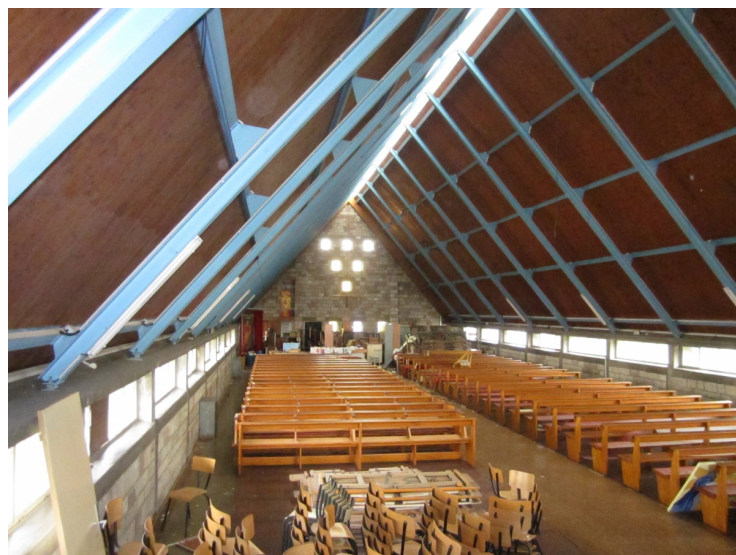
La charpente métallique mise au point par Jean Prouvé libère l'espace de la nef de tout point d'appui intermédiaire.
