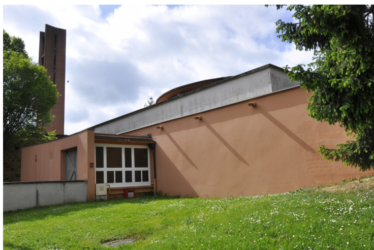
La seconde entrée, en façade nord.
