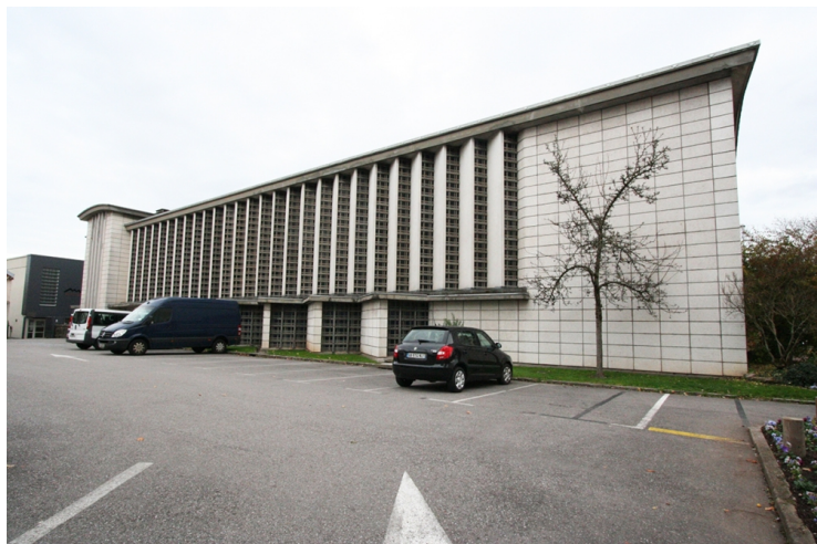
Les façades latérales se composent d'une série de voiles en dents de scie.
