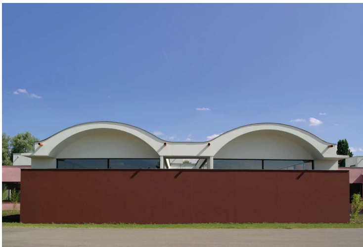
Murs et couvertures des salles de classe sont séparés par une fente de lumière.
