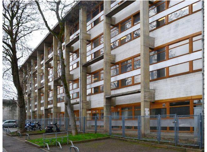
*Sur rue, la trace des planches de coffrage est visible sur la structure de béton armé, caractéristique du mouvement brutaliste alors en vogue.*
