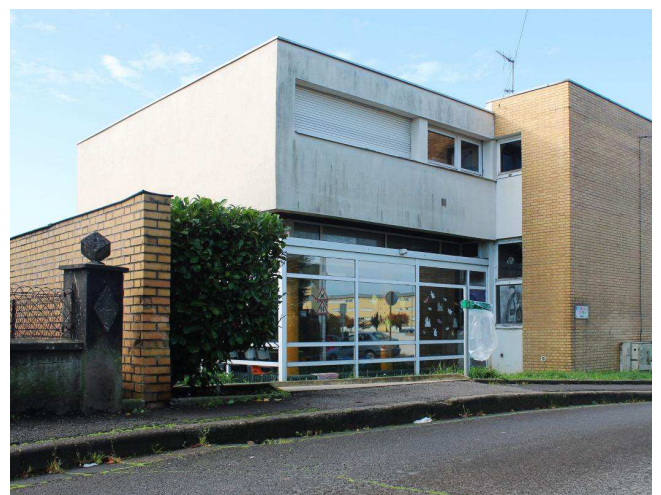
Le bâtiment d'entrée rompt avec la discrétion de l'école et se dresse dans la rue.
