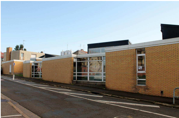
Depuis la rue Saint-Exupéry, les murs, les baies et les toits révèlent la présence de chaque salle de classe.
