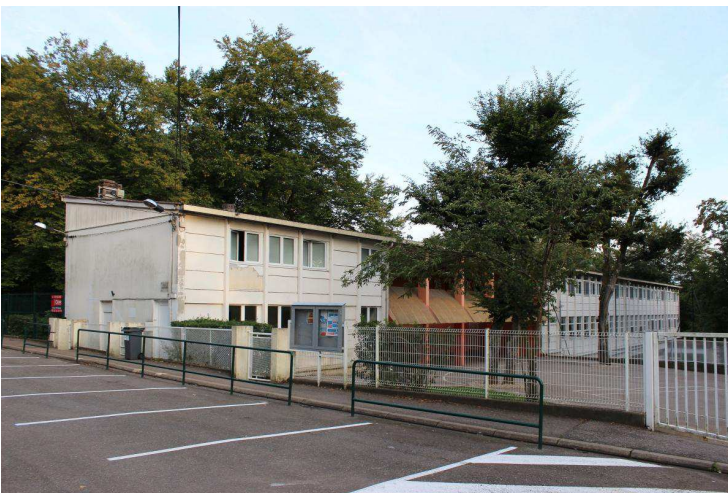
L'école primaire, toute en longueur, se décompose en trois séquences : les logements de fonction à gauche, puis le préau et enfin les salles de classe.
