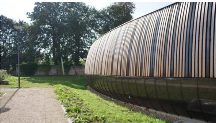
Une partie de la façade est couverte d'un bardage vertical en bois.
