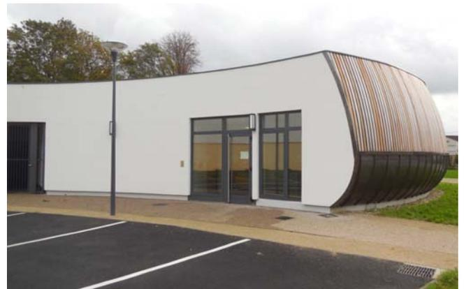
Béton enduit, lames de bois et plaques de cuivre en soubassement sont les trois principaux matériaux employés.
