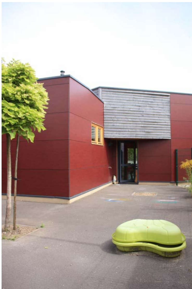
Les panneaux colorés et le bardage bois alternent en façade.
