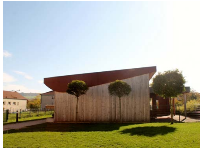
La façade côté parking étant fermée, le bâtiment se tourne naturellement vers les jardins. Source : Photographie Aline Cuny / LHAC / ENSA-Nancy Droits : URCAUE Lorraine
