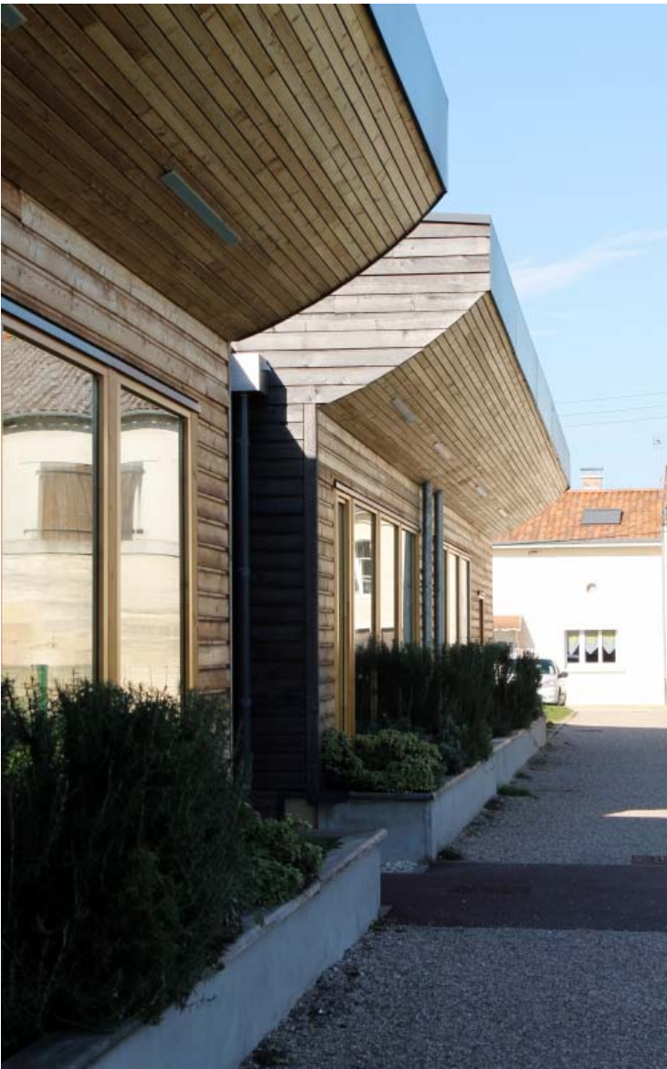
La forme de l'avant-toit donne une dynamique à l'édifice. Source : Photographie Aline Cuny / LHAC / ENSA-Nancy Droits : URCAUE Lorraine
