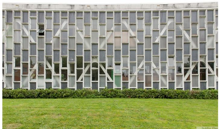
Les façades sont rythmées par un ensemble de meneaux et de traverses qui perturbent la perception des niveaux. La structure porteuse transparait derrière la façade-rideau.
