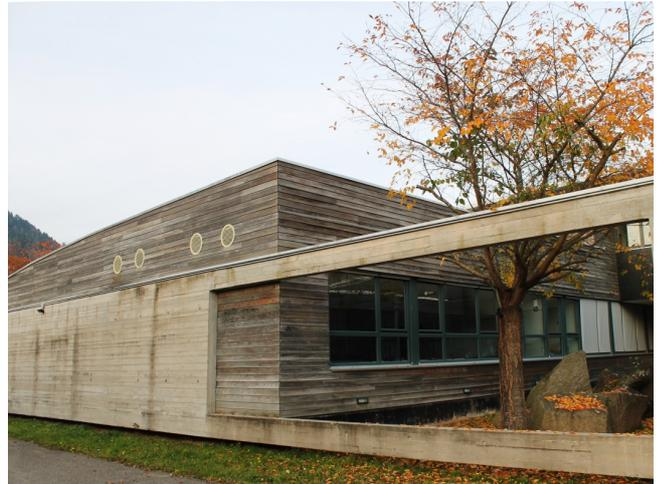
*L'épiderme du mur de béton ajouré laisse voir l'empreinte des planches du coffrage en un si dialogue avec le bardage de bois.*
