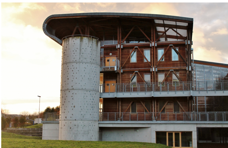
La colonne de béton accueille les circulations verticales et fait office de mur d'escalade.
