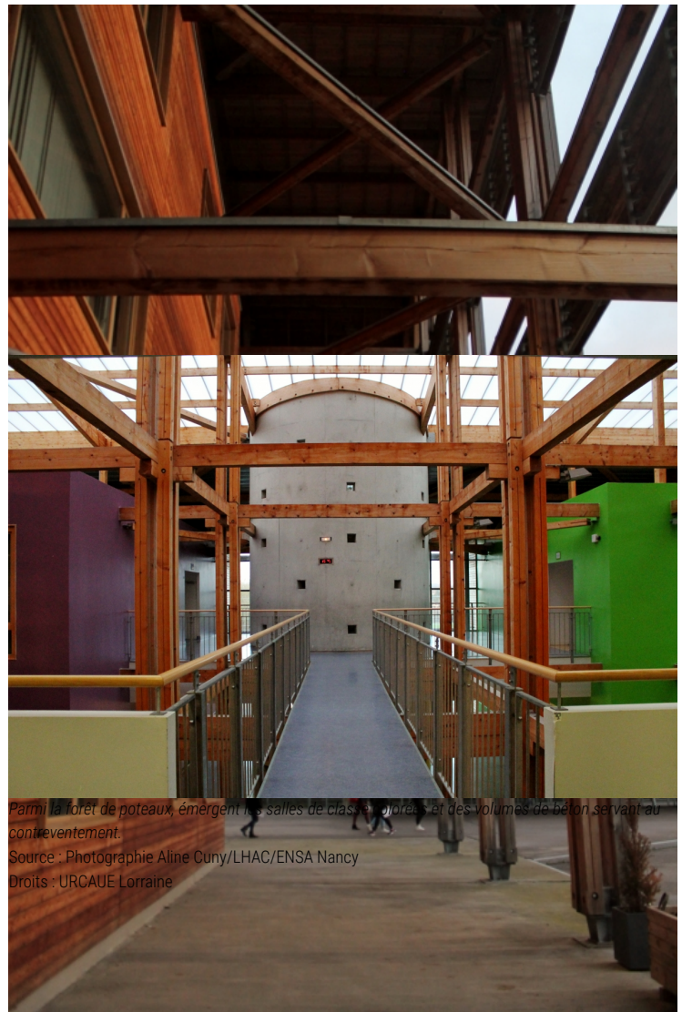
Le bois est utilisé aussi bien en structure qu'en bardage. Source : Photographie Aline Cuny/LHAC/ENSA Nancy Droits : URCAUE Lorraine
