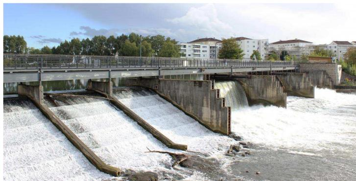
En cas d'augmentation du volume de la rivière, l'ouvrage s'efface pour laisser l'eau s'écouler.
