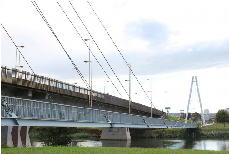
La passerelle de la Méchelle et le pont de la Concorde voisinent tout en s'opposant nettement par leurs formes et leurs matériaux.
