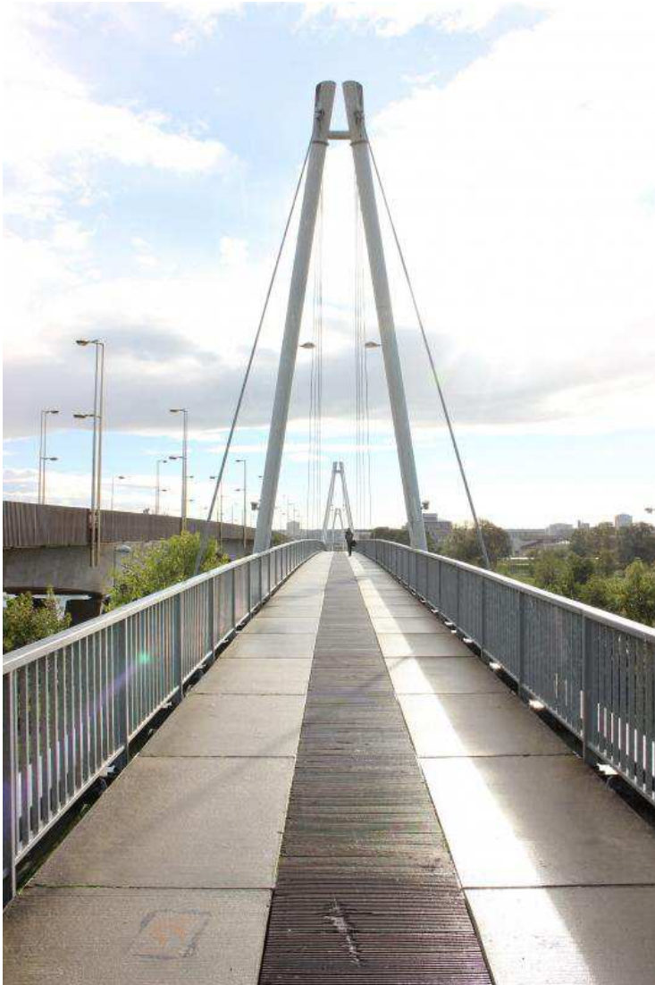
La voie de circulation, associant deux matériaux, est proportionnée aux flux piétons et cyclistes pour lesquels elle est conçue.
