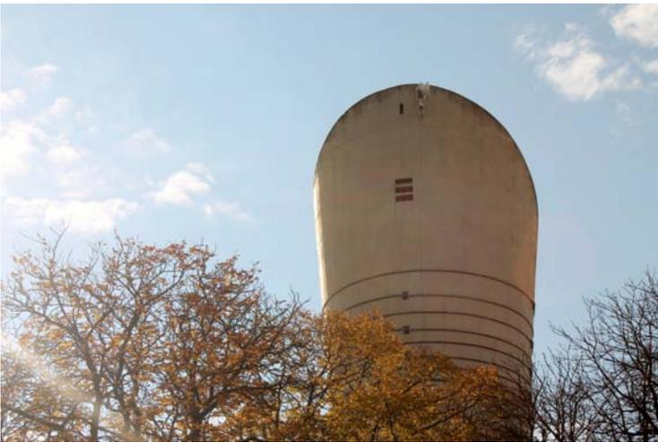
*Le château d'eau a été réalisé grâce à un béton blanc.*
