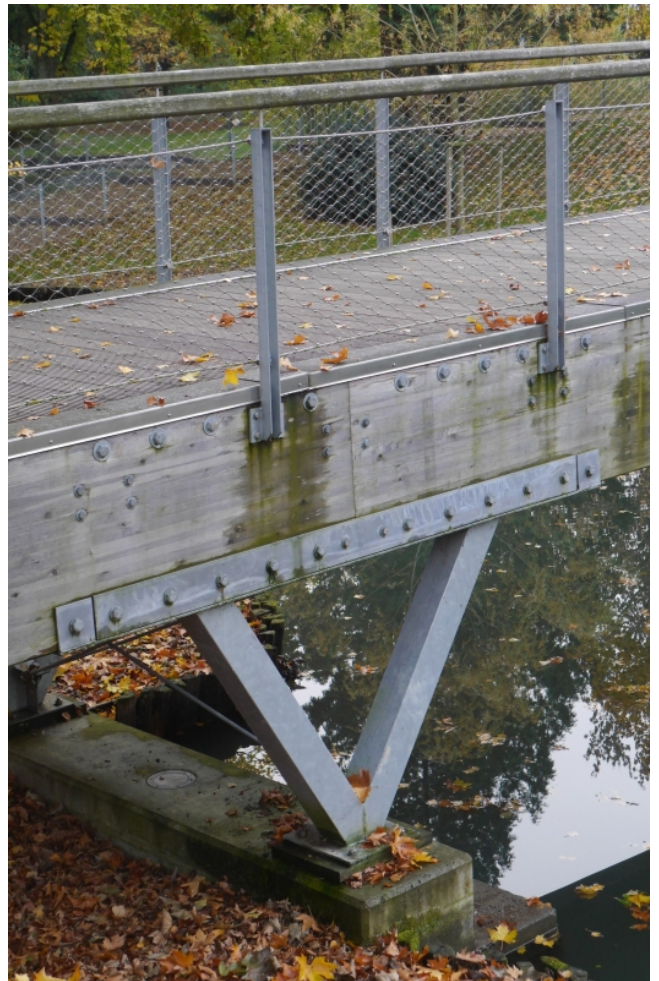
Métal et bois s'allient harmonieusement pour réaliser cet ouvrage.
