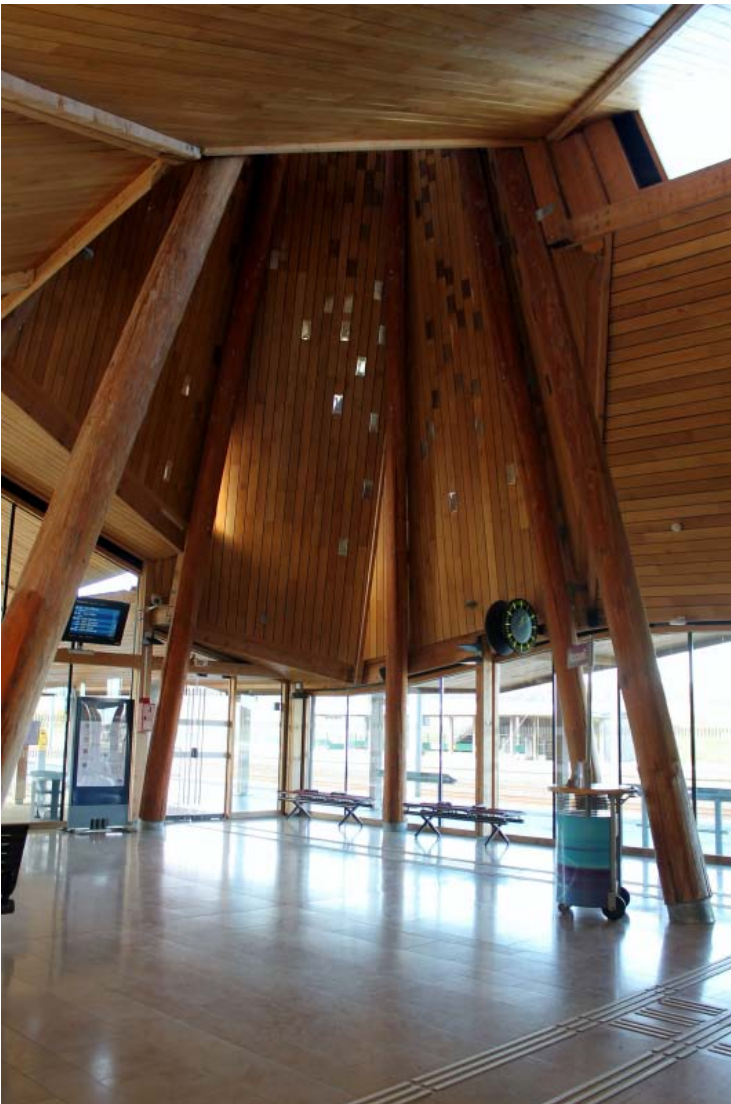
Le jeu des poteaux obliques renforce la dynamique des espaces intérieurs. Source : Photographie Aline Cuny / LHAC / ENSA-Nancy Droits : URCAUE Lorraine
