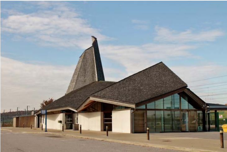
Les formes géométriques de la toiture composent une allégorie du village meusien. Source : Photographie Aline Cuny / LHAC / ENSA-Nancy Droits : URCAUE Lorraine
