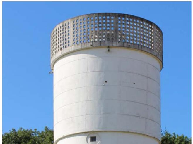
Les parois en ressaut du dernier niveau dissimulent une plateforme extérieure.
