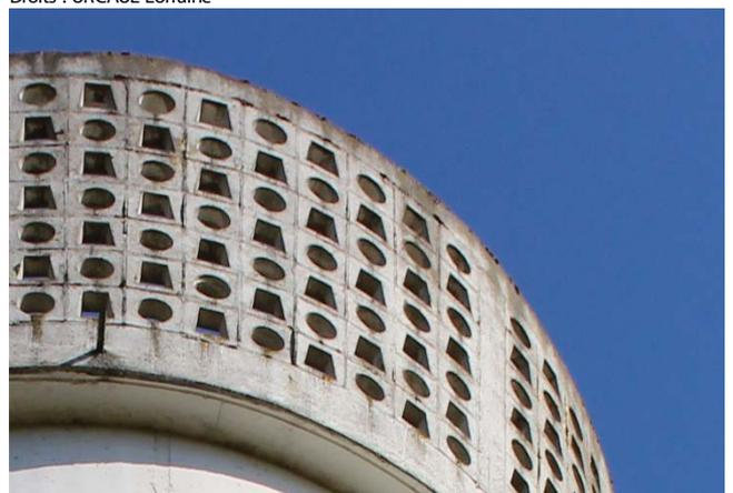
L'effet moucharabieh permet d'alléger la structure massive du château d'eau.
