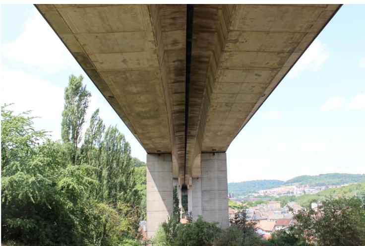
S'étendant sur près de 415 mètres de long, le tablier est constitué d'une double poutre-caisson.
