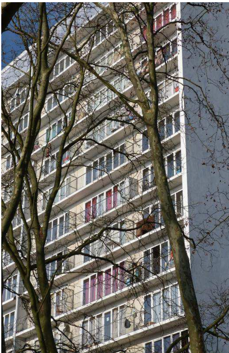
Au sud, les logements s'ouvrent largement pour profiter du soleil et d'une superbe vue sur la ville.
