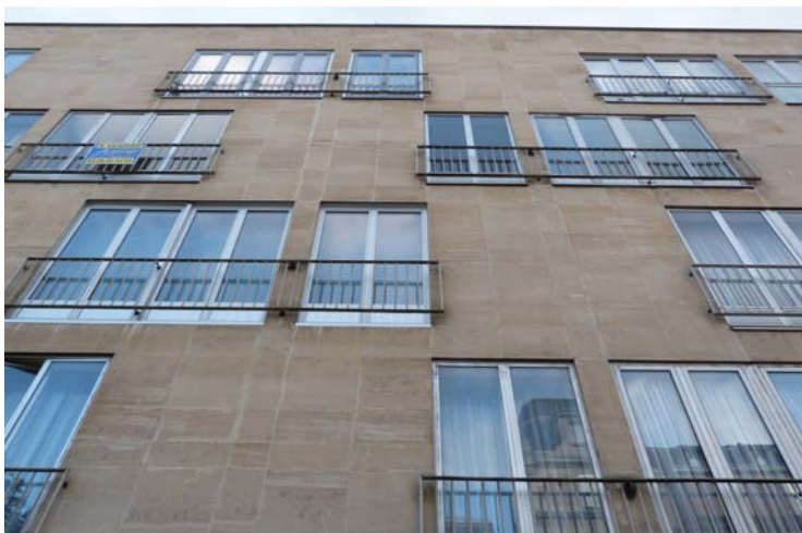
Le parement de pierre révèle la trame structurelle par de discrètes bandes verticales plus étroites que leurs voisines.
