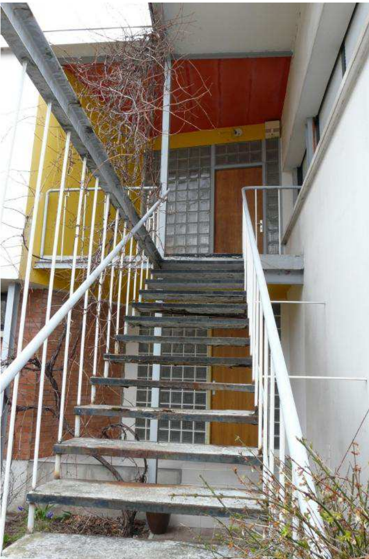
Dans la configuration initiale, l'escalier menait à la porte d'entrée principale.
