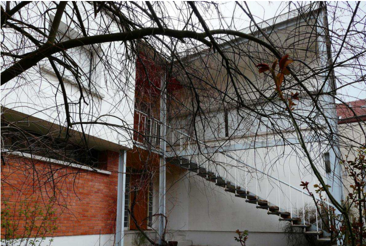
La brique du soubassement forme contrepoint à la structure métallique.
