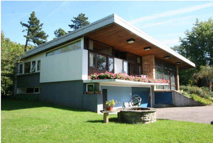
Un important débord de toiture protège la façade principale.
