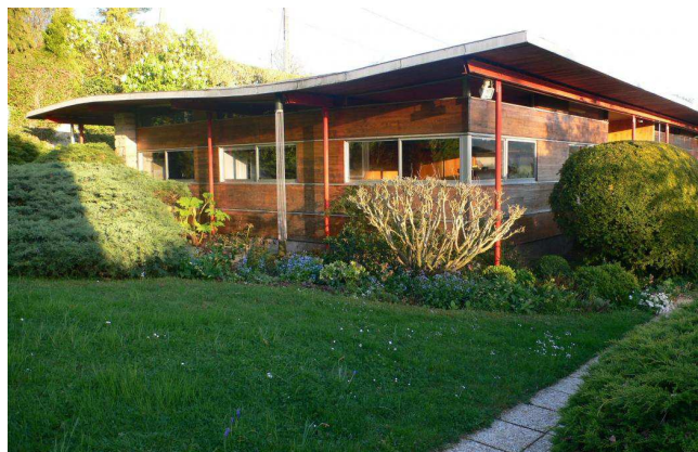
Les panneaux de bois "Rousseau" permettent de générer la courbure du toit.
