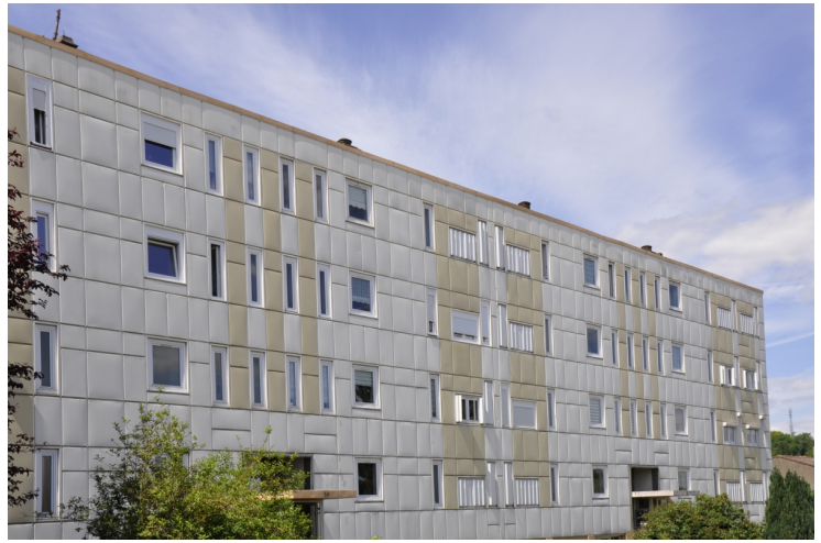
Les façades des immeubles collectifs sont animées par l'alternance de deux combinatoires associant panneaux colorés et fenêtres de taille différentes.
