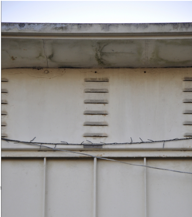
Les grilles de ventilation de la sous-face de couverture créent un motif régulier en couronnement de façade.
