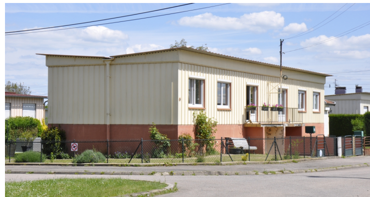
Exemple de maison d'ouvrier, reconnaissable aux nervures verticales de ses façades et à son soubassement en béton armé.
