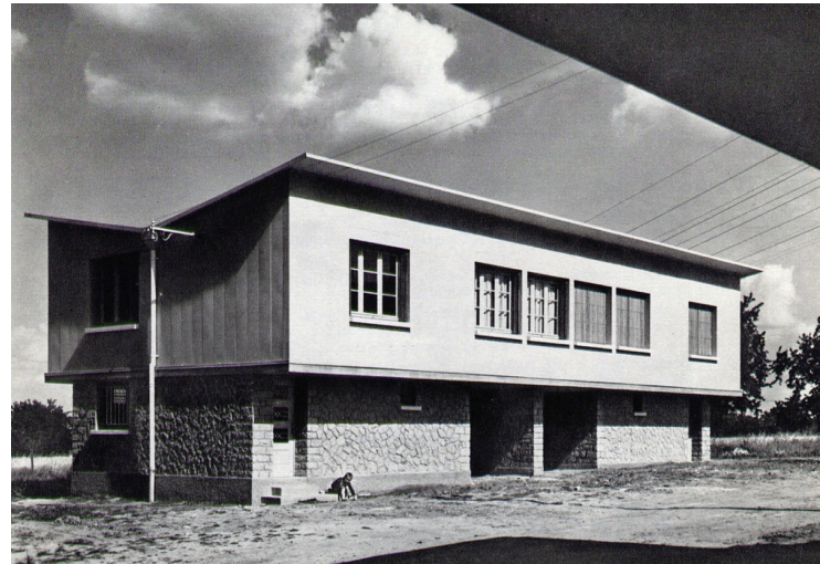
Le volume accueillant les pièces de vie de la maison de cadre, réalisé en ossature métallique, repose sur un rez-de-chaussée constitué d'une maçonnerie de moellons appareillés.
