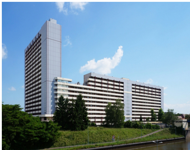
L'immeuble assemble deux typologies caractéristiques des Trente Glorieuses : la tour et la barre.
