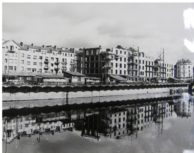
Les immeubles de la place Pinau à Epinal en cours de construction (s.d., autour de 1945-1950)
