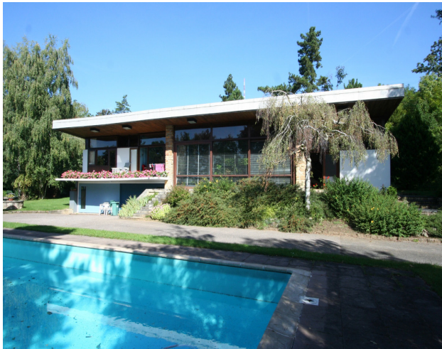
L'alliance des matériaux, la qualité de la composition du plan et des façades, ainsi que le soin apporté aux détails font de cette maison construite par Dominique-Alexandre Louis à la fin des années 1950, un exemple représentatif des réalisations lorraines.
