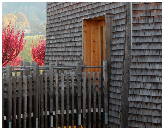
Le bois permet des usages multiples dans l'architecture contemporaine, comme on le voit ici à Tendon (Vosges)
