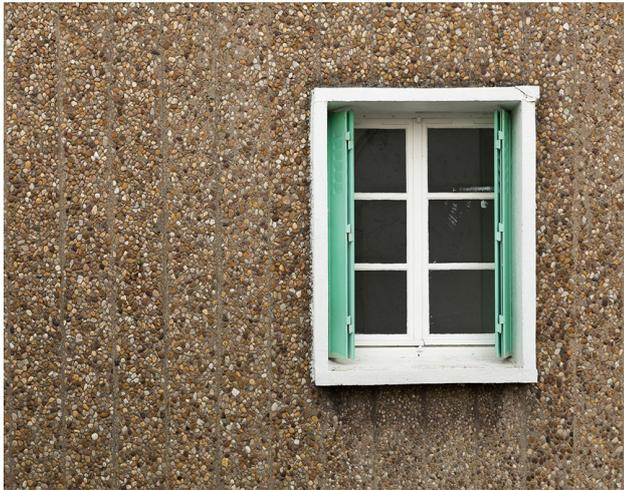
Les murs des maisons de la Cité Bellevue de Creutzwald sont constitués par des modules préfabriqués en béton, parés de gravillons.
